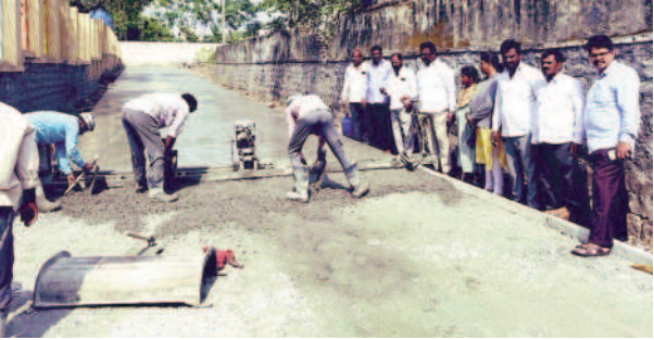
రోడ్డు నిర్మాణం పనులను పరిశీలిస్తున్న కార్పొరేటర్ పన్నాల
